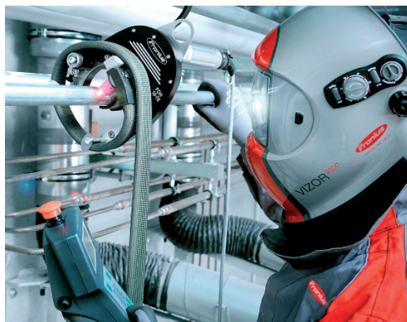
Fot. 7. Urządzenia do spawania orbitalnego firmy Fronius, dzięki dużej elastyczności, mogą być stosowane w różnych dziedzinach przemysłu
