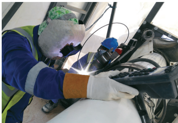
Rys. 6. Oprzyrządowanie do napawania na instalacji, w trudnych warunkach środowiskowych
