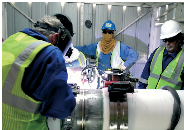
Rys. 6. Spawanie rur grubościennych z zastosowaniem głowicy otwartej i techniki wąskoszczelinowej
